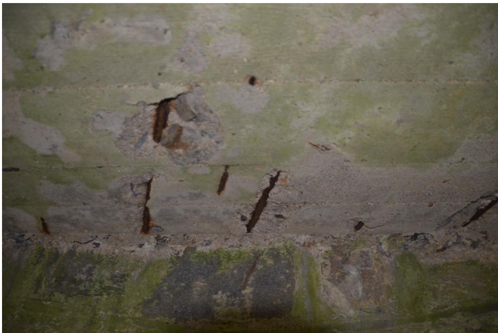
Obr.G34-25 Detail podhledu v pravé části NK mostu při první podpěře, pravobřežní opěře. Pohled proti směru staničení a vzhůru,
