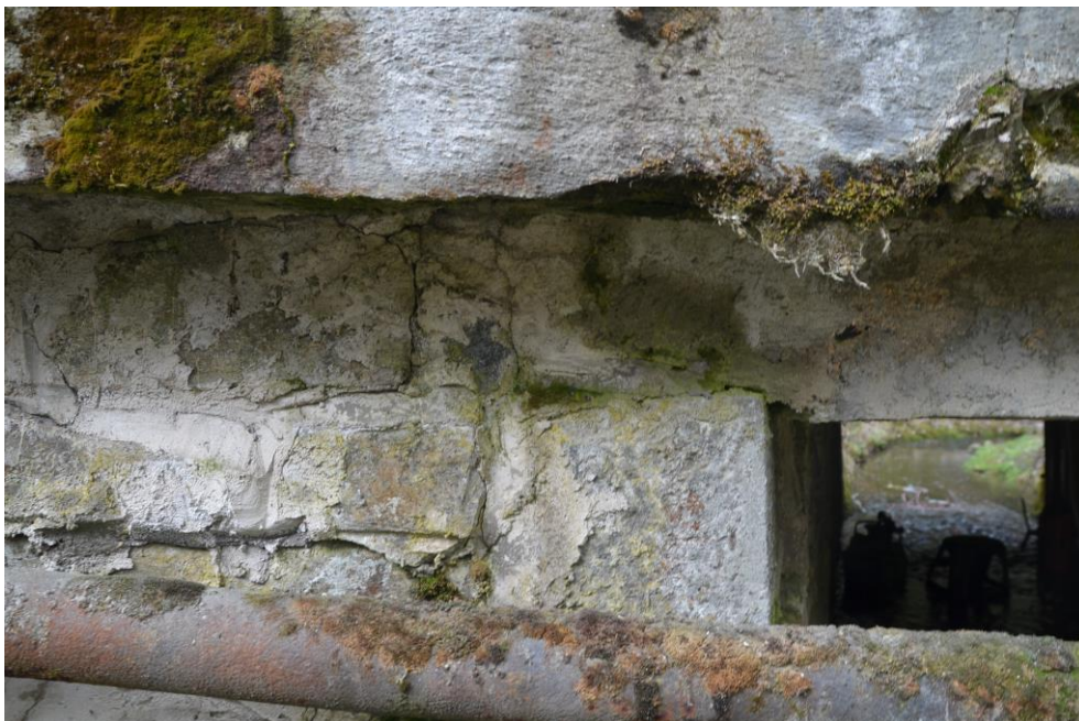
Obr.G34-17 Detail uložení konce ŽB desky (levá fasáda) na druhé podpěře, levobřežní opěře. Pohled zleva doprava, po vodě,
