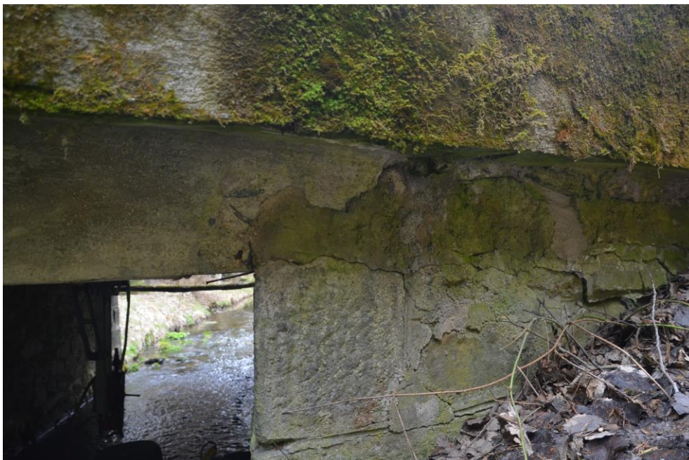
Obr.G34-21 Detail uložení konce ŽB desky (pravá fasáda) na druhé podpěře, levobřežní opěře. Pohled zprava doleva, proti po vodě,
