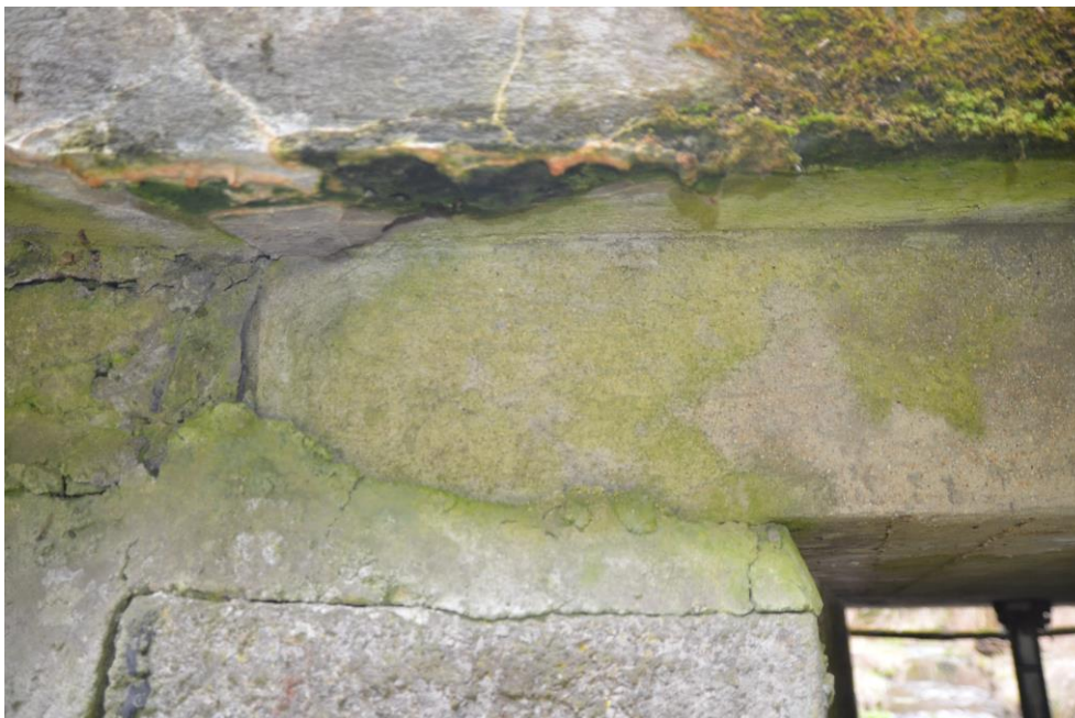
Obr.G34-19 Detail uložení začátku ŽB desky (pravá fasáda) na první podpěře, pravobřežní opěře. Pohled zprava doleva a proti vodě,
