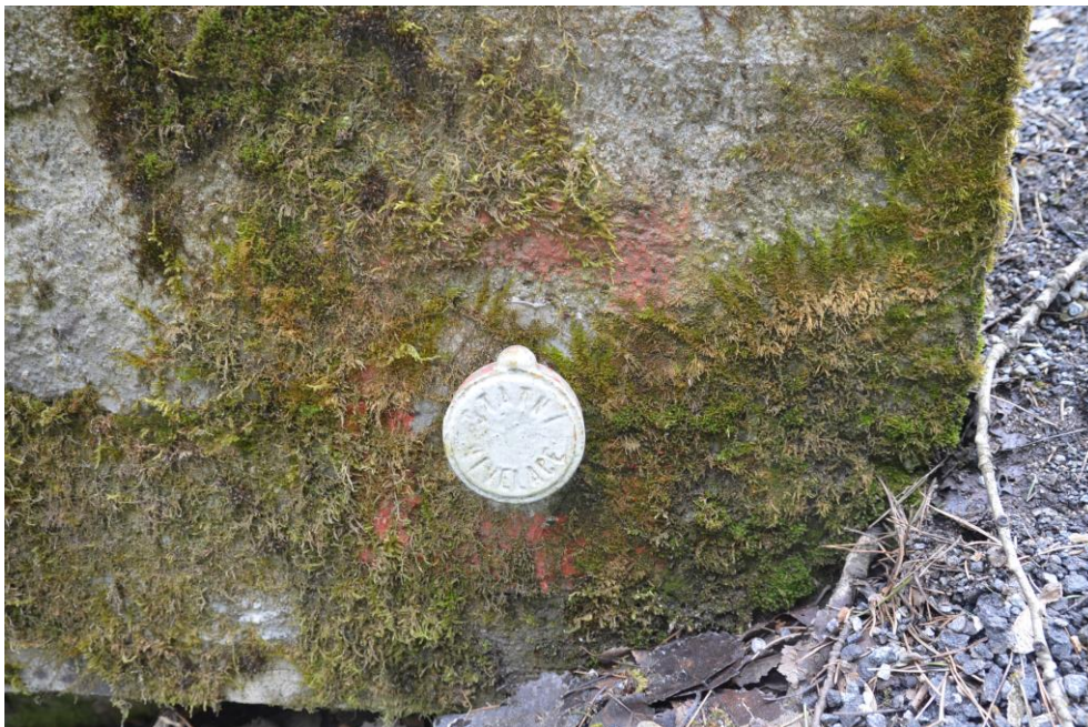
Obr.G34-36 Detail konce pravostranné římsy. Pohled zprava doleva, - na konci pravostranné římsy nad druhou podpěrrou, levobřežní opěrou je umístěn bod státní nivelace.
