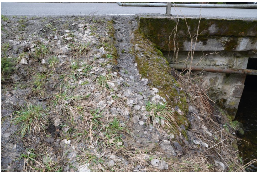
Obr.G34-32 Detail skluzu za druhou podpěrrou, levobřežní opěrrou. Pohled zleva doprava,
