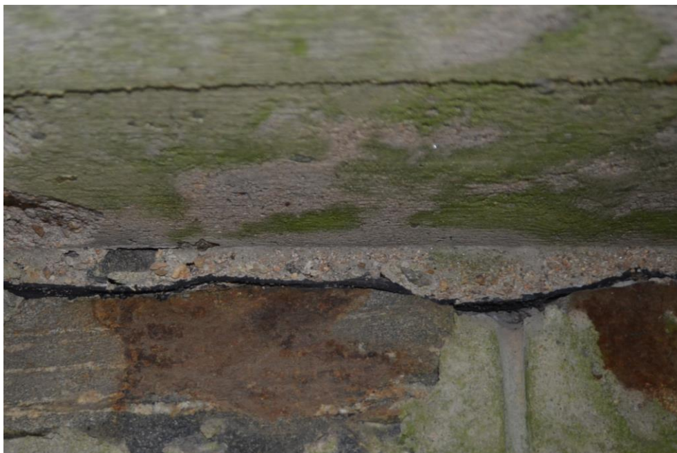
Obr.G34-34 Detail uložení NK na druhou podpěry, levobřežní opěru. Pohled ve směru staničení, - NK je na opěře uložena přímo, na lepenku a vrstvu cementového betonu.
