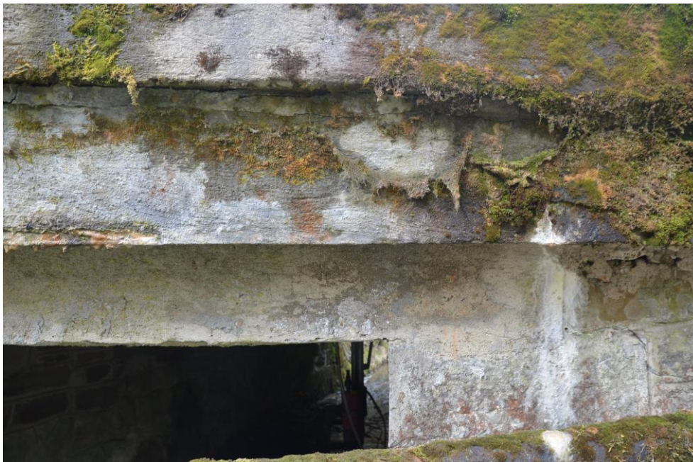
Obr.G34-15 Detail uložení začátku ŽB desky (levá fasáda) na první podpěře, pravobřežní opěře. Pohled zleva doprava, po vodě a proti směru staničení,
