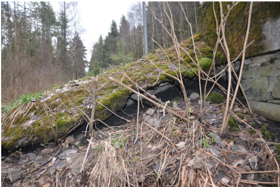
Obr.G34-33 Detail skluzu za druhou podpěrrou, levobřežní opěrrou. Pohled ve směru staničení, - vlivem srážkové vody došlo k podemletí betonových skluzů.
