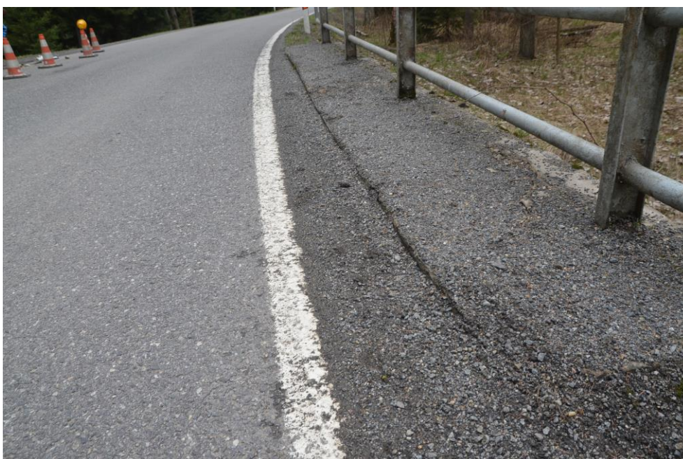
Obr.G34-30 Detail vozovky na mostě při levostranné římse. Pohled proti směru staničení a dolů,
